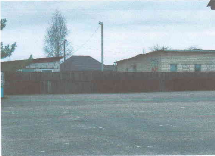
16.04.2021г. – Литер б – ограждение (участок 3)
