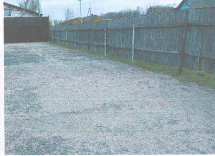
16.04.2021г. – Литер б – ограждение (участок 4)
