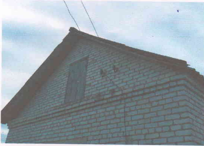
16.04.2021г. – Литер д – сеть электроснабжения
