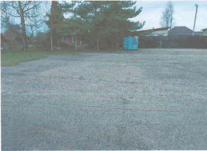
16.04.2021г. – Литер а – покрытие
