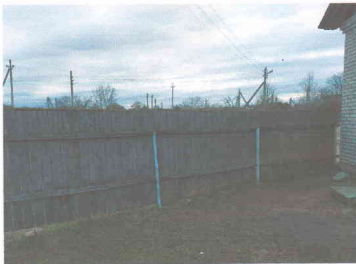
16.04.2021г. – Литер б – ограждение (участок 6)
