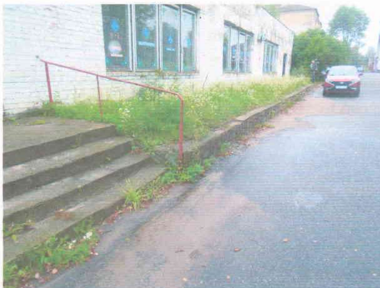
31.08.2020 г. Литер а – Подпорная стенка
